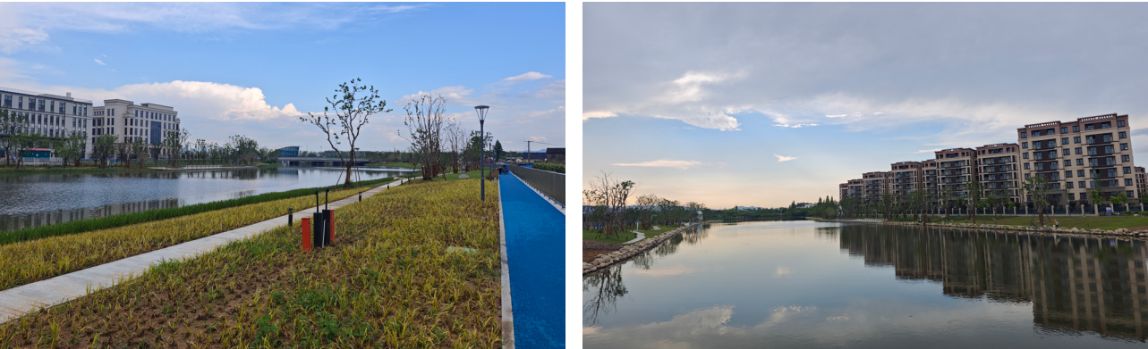
枢纽水利先导工程
