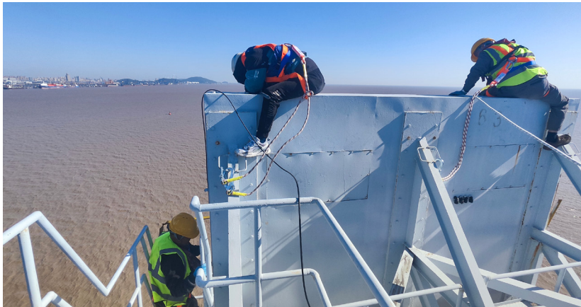
杭州湾跨海大桥开展航标改造工作。
