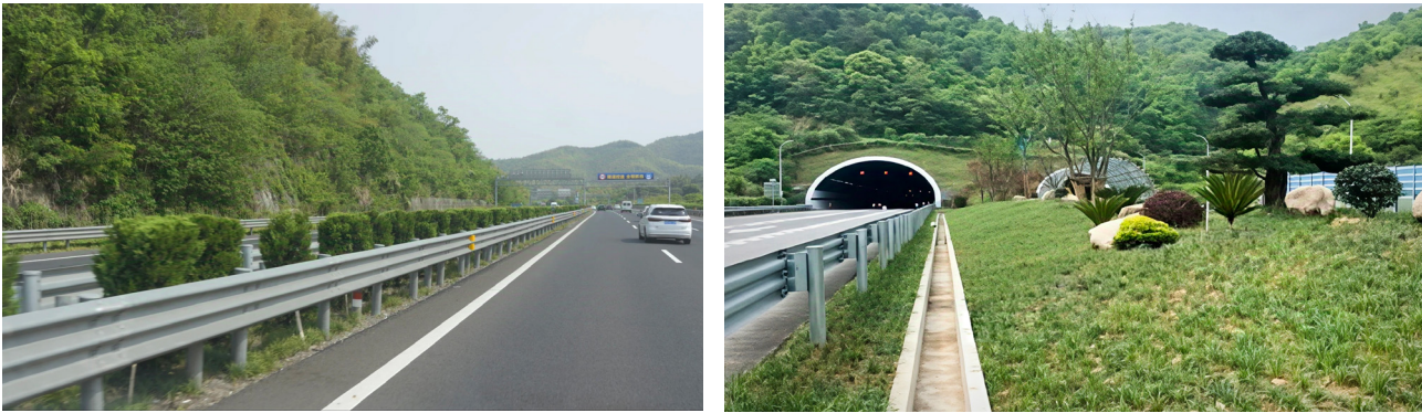
高速路面养护
