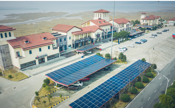
象山服务区光伏改造项目
